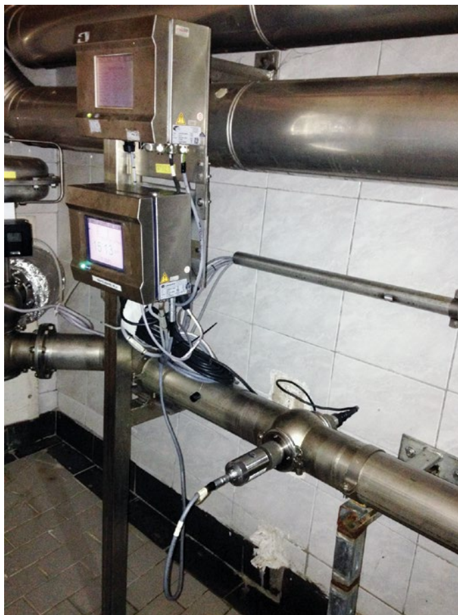
Fig 2. Controlere Hach 410 – instalare tipică
